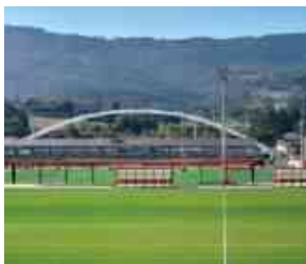
Instalaciones de Lezama Athletic Club (Vizcaya)
